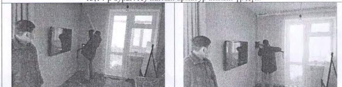
15,16-р зураг. Ханын арматурчлалыг GPR Live маркийн багажаар шалгаж байна.
