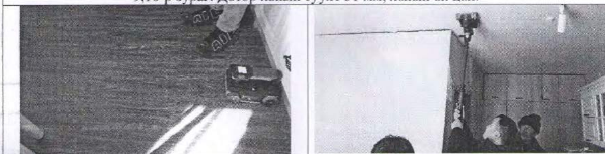
11-р зураг. Шалны доорх бетоны арматурчлал, хучилтын арматурчлалыг шалгав.
